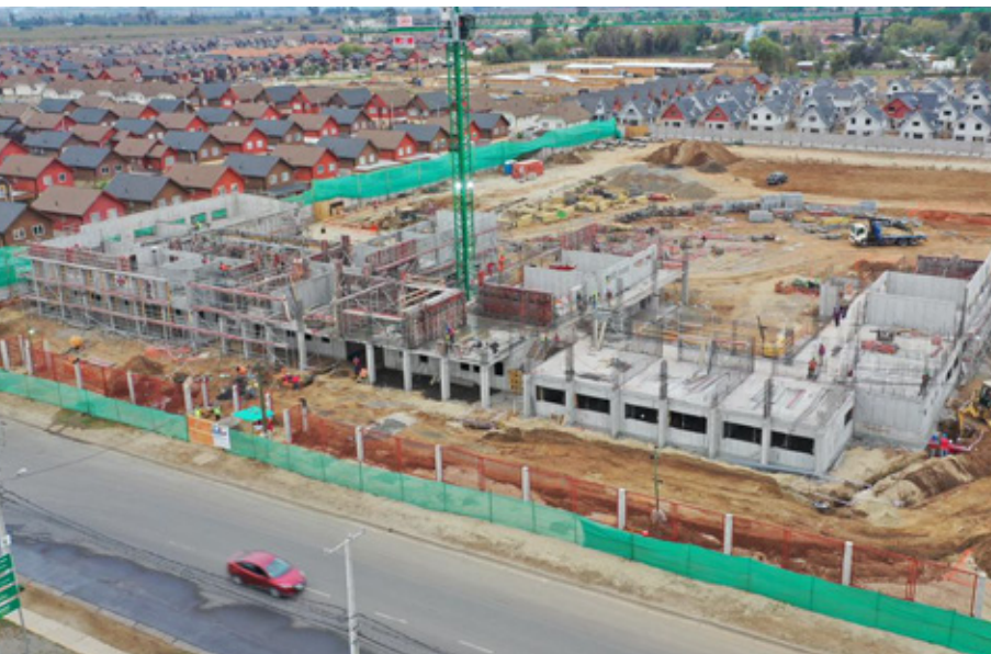
Avance obra: 35% al 31 de mayo
